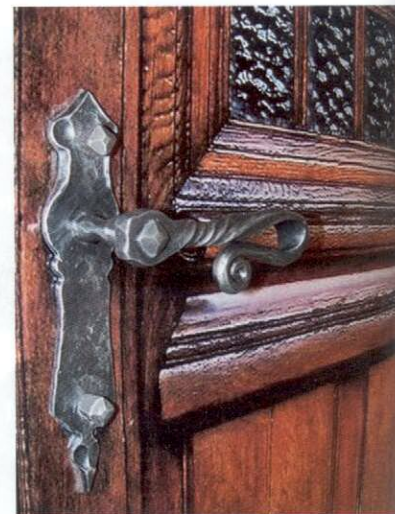
Nach einer Fotovorlage wurde alles, außer dem geschmiedeten Türgriff, auf die Ganzglastür digital gedruckt
